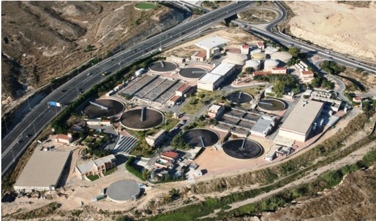
Figure 11. Station de traitement des eaux usées de Rincón de León (source : SUWANU).
