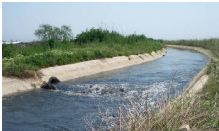
Figure 7. Canal d'irrigation et point de mélange des effluents de la station d'épuration de Thessalonique avec l'eau de la rivière Axios (Ilias et al., 2014).
