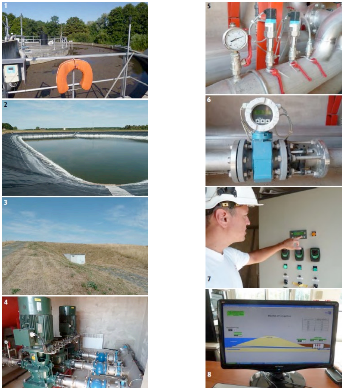
Figure 6. Le dispositif de production et de distribution d'eaux usées traitées. 1) La station d'épuration. 2) La lagune de traitement tertiaire et de stockage des eaux usées traitées. Arrivée d'eau épurée à l'extrémité opposée du bassin. Le 3 août 2015 : niveau d'eau bas à 1,78 m (4 m en début de saison d'irrigation). 3) Station de pompage au pied de la lagune. 4) Équipement de la station de pompage : 3 pompes pour la mise en pression du réseau irrigation. (Cerema, 2016).
